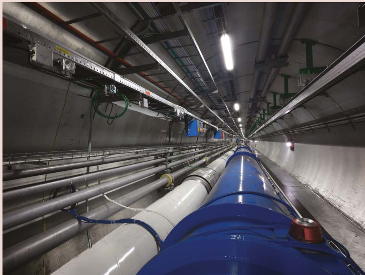
a. Il tunnel di LEP/LHC nel sottosuolo tra Ginevra e il Giura. Le linee dei fasci passano all'interno del tubo blu.
