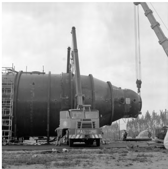
Costruzione dei Laboratori Nazionali di Legnaro.
