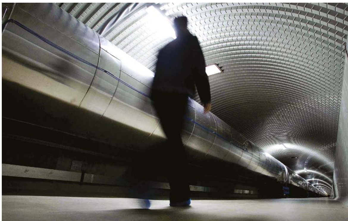
b. Foto del tunnel dell'esperimento Virgo a Cascina, nei pressi di Pisa. La camera da vuoto ha un diametro di 1,2 m ed è rivestita di isolante termico utilizzato durante la bakeout , per diminuire la dispersione termica e, durante il funzionamento, per limitare le escursioni termiche.
