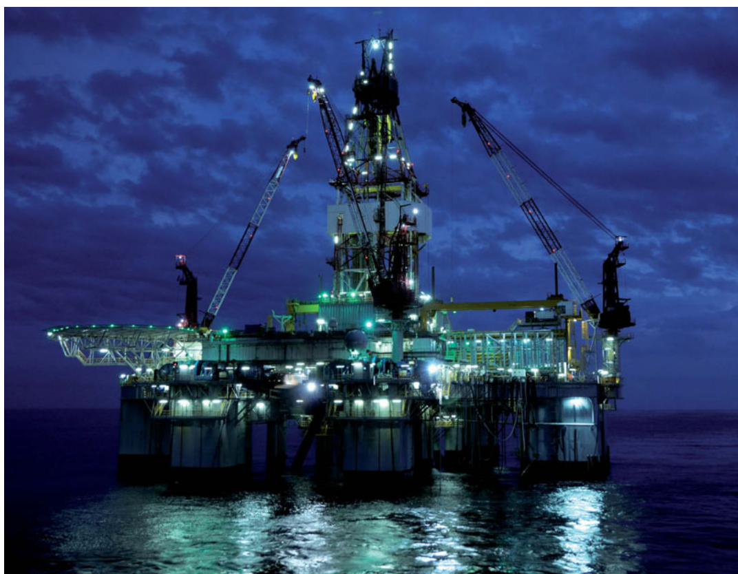
b. Piattaforma petrolifera. Le energie fossili, pur provenendo indirettamente dal Sole, non sono considerate illimitate dati i lunghi tempi di rigenerazione.
